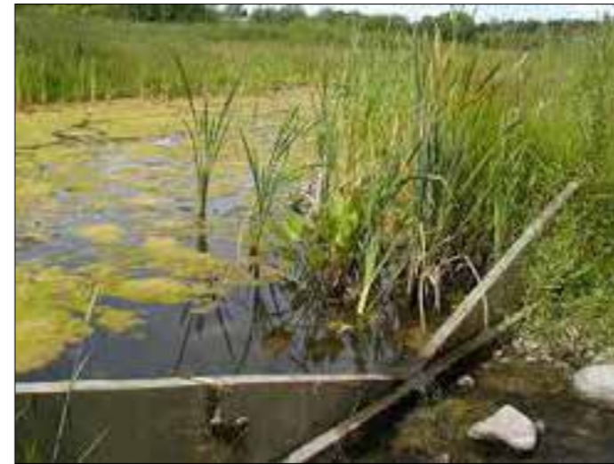
Bild 26. exempel på dämme och överfall för bäcken.
