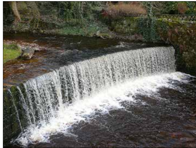
Bild 25. exempel på dämme och överfall mellan dammarna.
