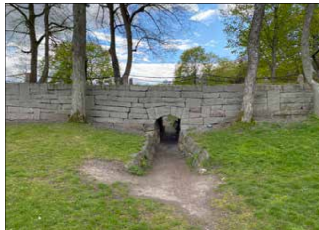
Bild 05 visar kulverten under vägen.
