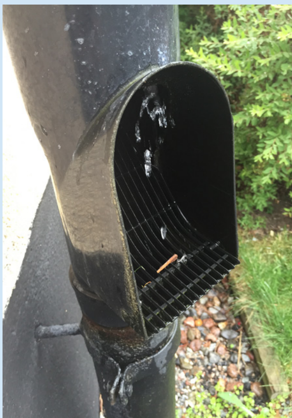
Lövsil monterad på stuprör.
