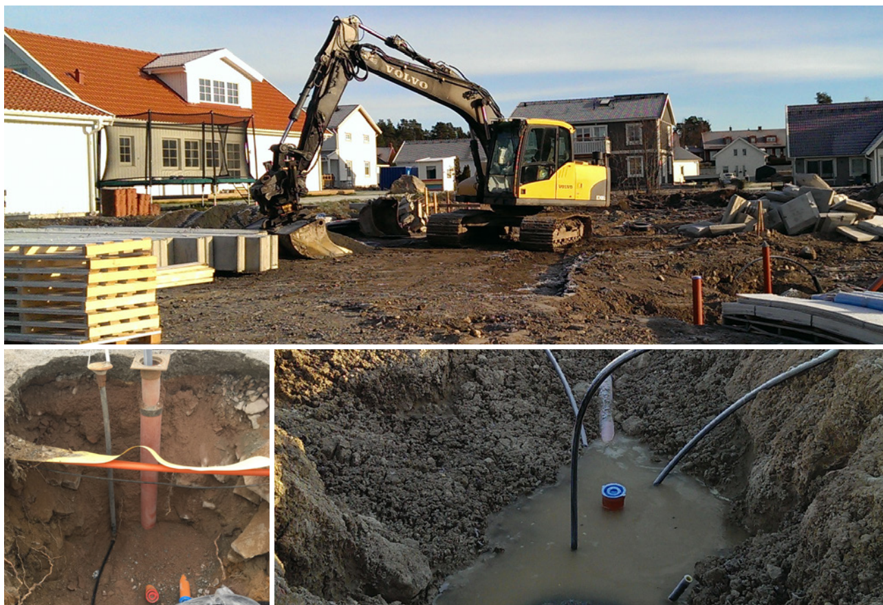
Utbyggnad av privata VA-ledningar till förbindelsepunkter strax utanför fastighetsgräns.
