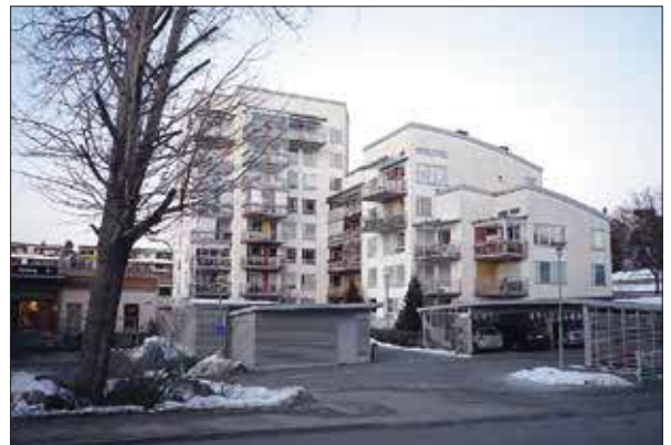
Sjöbergs centrum kan förtätas och rustas upp.
