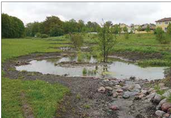
Dagvattendamm under uppförande. FOTO: SOLLENTUNA KOMMUN
