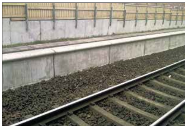
Spårnära bullerskärm vid Sollentuna station.
